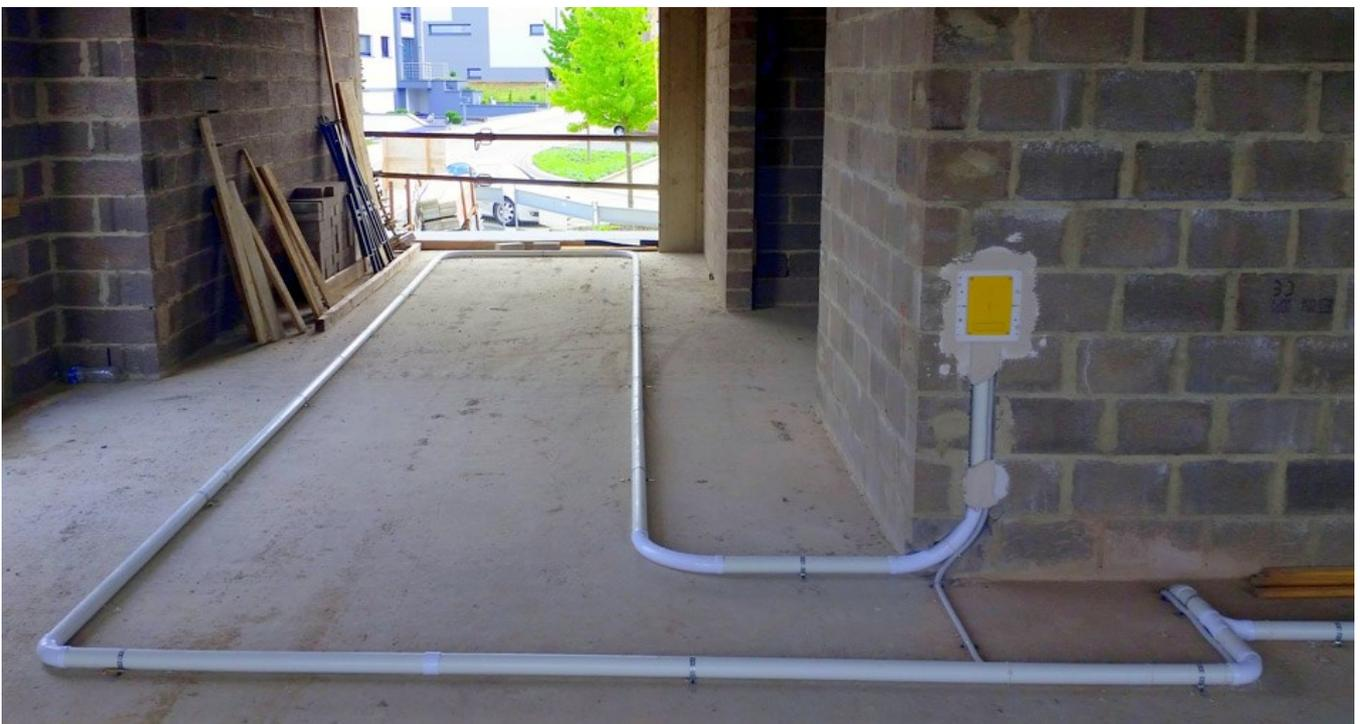
Wie Sie sehen können, können Sie die 2" Staubsaugerrohre weiterhin verwenden, jedoch nur in Kombination mit den originalen extra langen Hide-a-Hose-Bögen. Die grauen Standardrohre sollten nicht verwendet werden.
